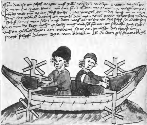
Abb. 157. Kriegsbarke mit Schauflerrädern. Entwurf von etwa 1430.
